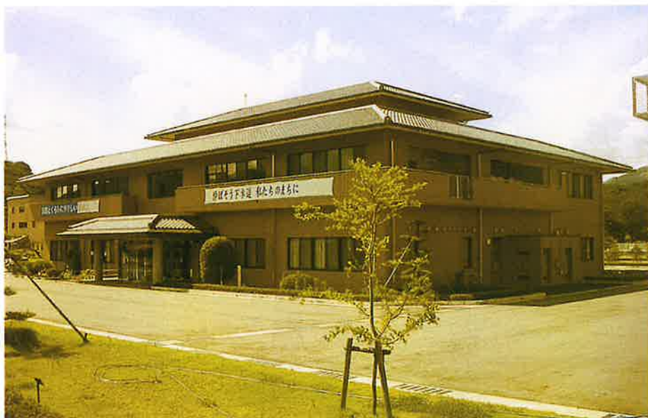
伊都浄化センター管理棟
