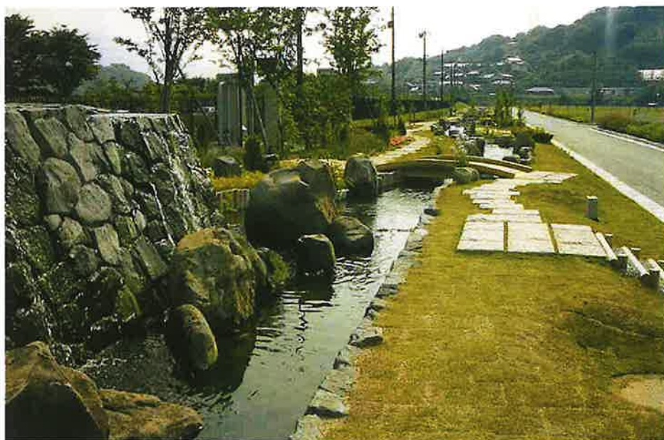
せせらぎ水路
