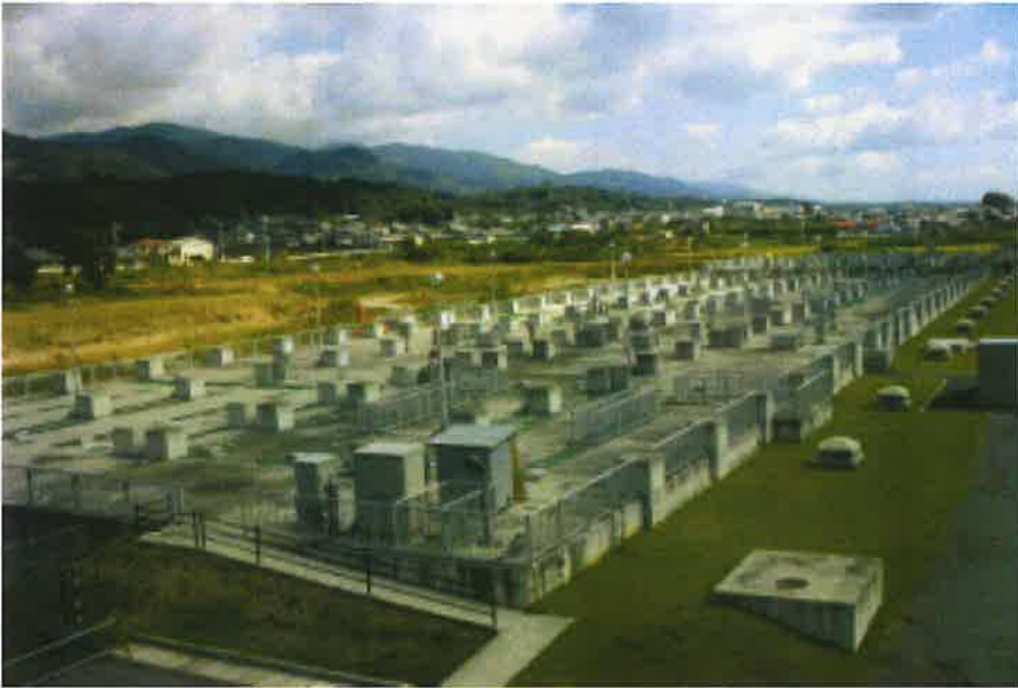
伊都浄化センター水処理施設
