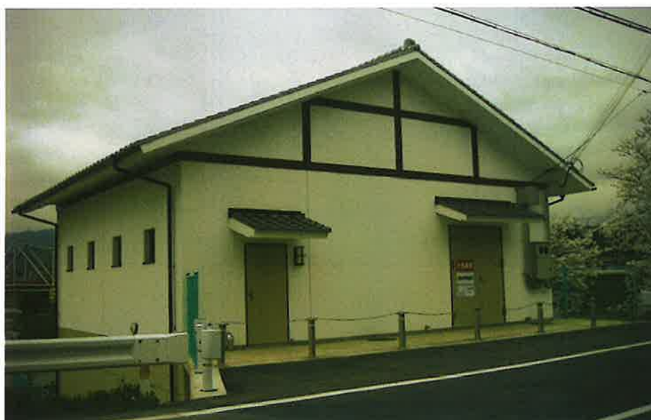
九度山中継ポンプ場
